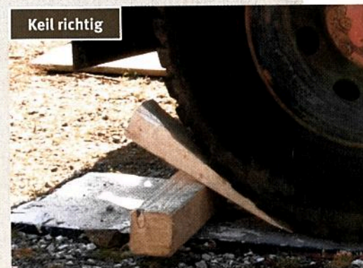
Richtig: steiler, bündiger Keil durch einfaches Unterschieben eines Kantholzes.
